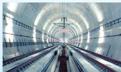
青函トンネル(1982年/昭和57年)
