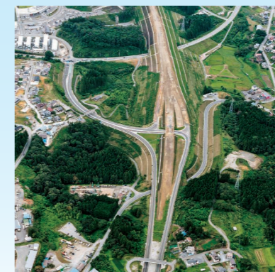
国道45号 陸前高田道路(2018年/平成30年)
