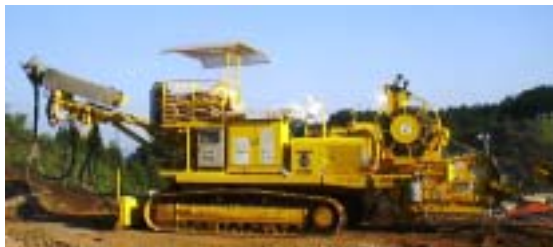
写真-3 スラリーショット吹付けロボット
