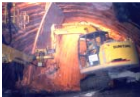
写真－1 中壁撤去状況（左専用エリクター、右ブローカー）
