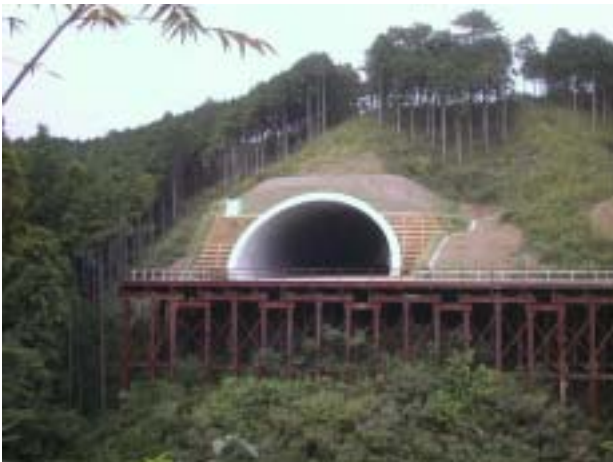
写真4 上り線西側坑口
