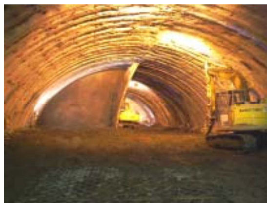
写真－2 上半切羽（斜路ロードマット使用）
