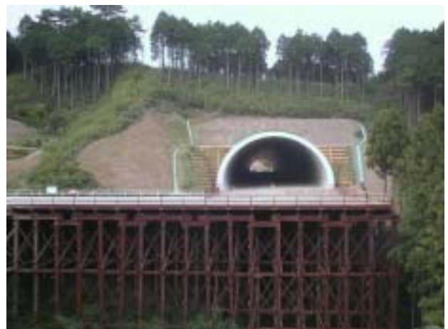
写真5 下り線西側坑口
