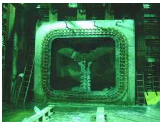
図 - 5 中間立坑到達状況
