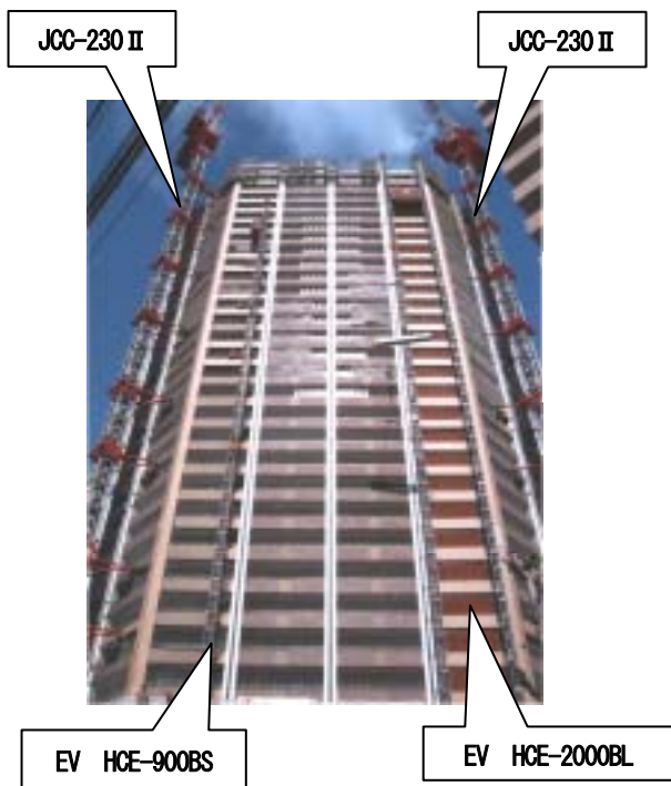
写真-2 揚重機器
