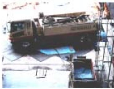
高揚程圧送ポンプ車
