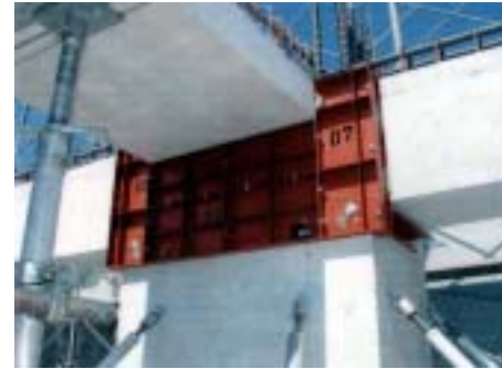
写真-12 パネルゾーン鋼製型枠
