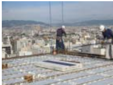
バルコニー設置
