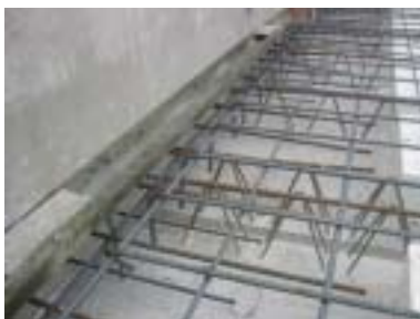
側溝型枠取付
