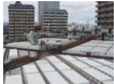
スラブ板設置
