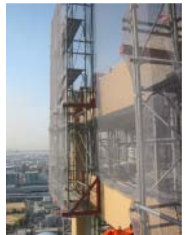
写真-10 スライディング足場架設状況
