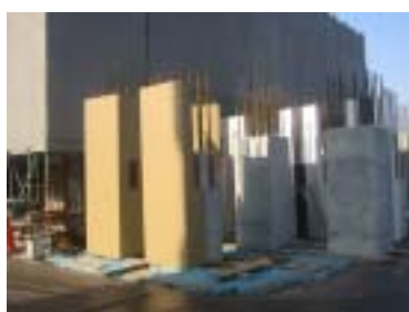
写真-9 PCa柱先行塗装状況
