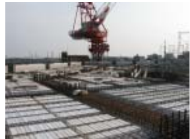
鉄筋材荷上げスラブ配筋
