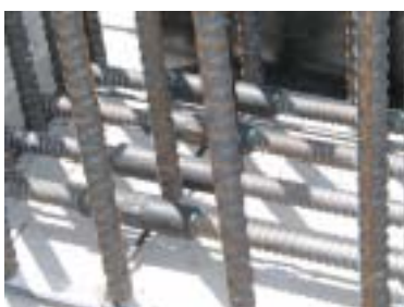
写真-8 エポキシ充填状況
