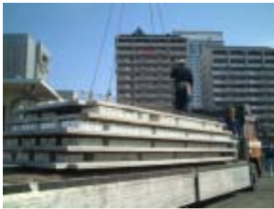
スラブ板搬入荷上げ
