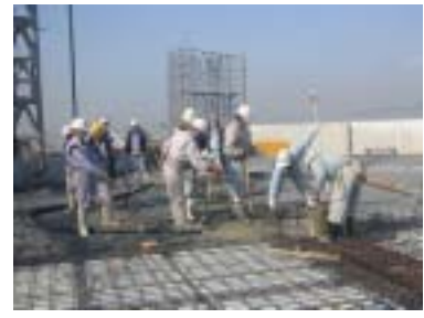
コンクリートポンプ打設
