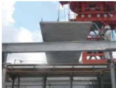
スラブ板吊り込み
