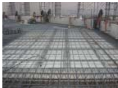
スラブ配筋・型枠施工
