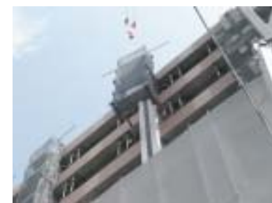
SL足場せり上げ
