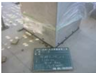
柱部グラウト入
