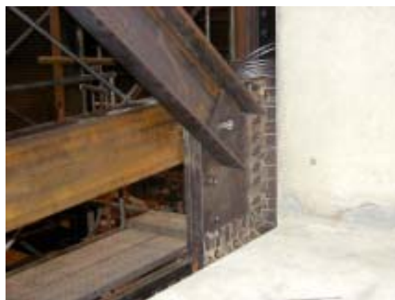
写真-4 仮止め部材設置
