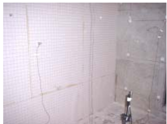
写真1 計測状況（正面はB壁とC壁）
