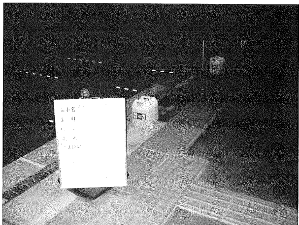
写真-13 施工区画の明示状況
