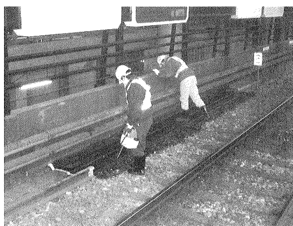
写真-7 浸透型防水剤 (CS-21/RS) 散布状況
