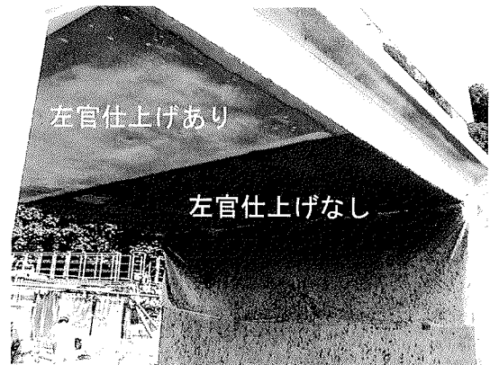
写真-1 左官仕上げ後の状況
