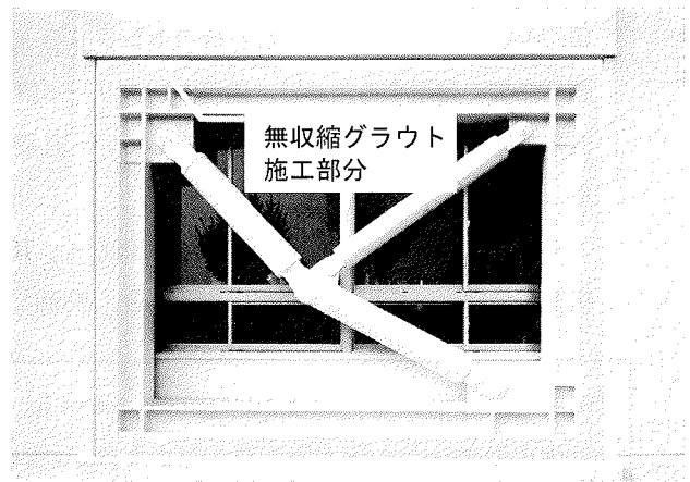
図-1 既存構造体へのトグル構法適用例
