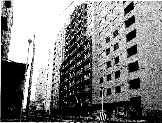
写真-5 竣工後全景
