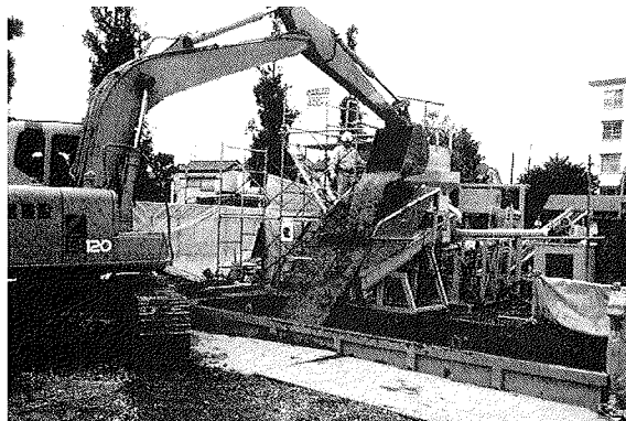
写真-2 泥土投入状況
