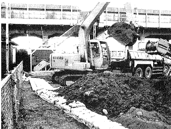
写真-4 改質土の積込状況
