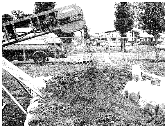
写真-3 搬出状況
