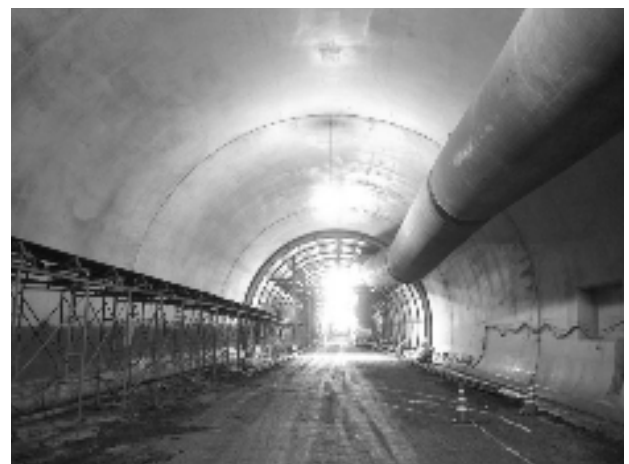
写真-11 中流動覆工コンクリート仕上がり状況
