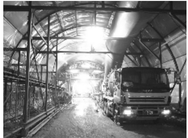
写真-10 3スパン連続覆工コンクリート養生台車
