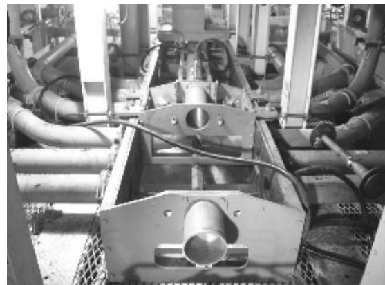
写真-7 配管切替で採用したスパイダーシステム
