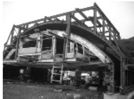
写真-1 実物大型枠幅 (10.1m×高さ 4.2m×奥行き 6.0m)
