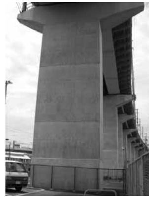
写真-10 P3の完成写真
