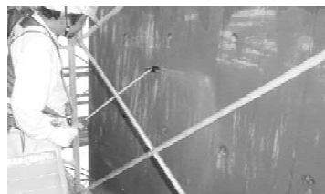
写真-8 被膜養生剤塗布
