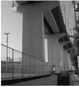
写真-1 施工前の東加島高架橋
