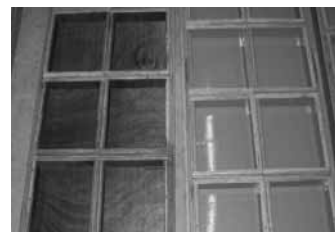
写真-1 左：ベニヤ型枠、 右：パネコート型枠
