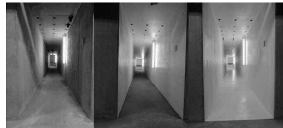
写真-5 地下ピットの塗装状況
