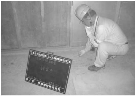
写真-4 エポサーチによる位置確認
