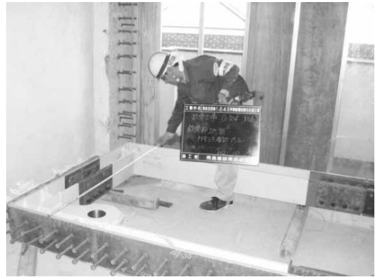
写真-6 組立寸法確認
