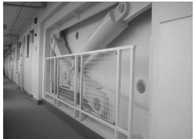
写真-11 角腕トグルとBT鋼(ブラッシュアップ後)
