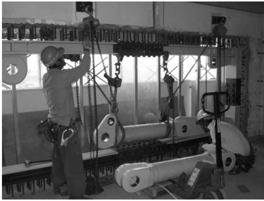
写真-9 腕部材取付
