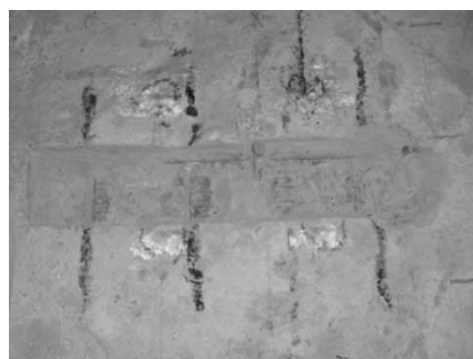
写真-3 主筋位置確認（ハツリ出し）
