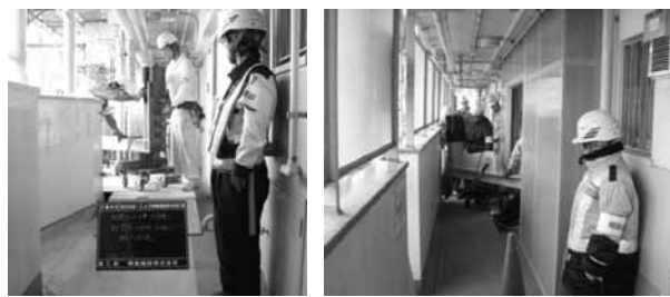
写真-2 鉄骨搬入状況
