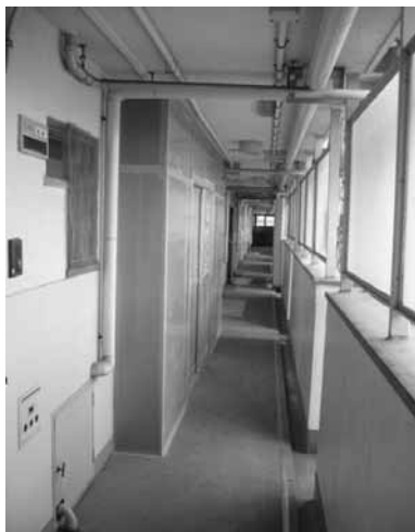
写真-1 仮設間仕切り設置状況（共用廊下面）
