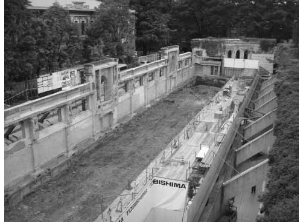
写真-9 既存建物の解体後の保存壁
