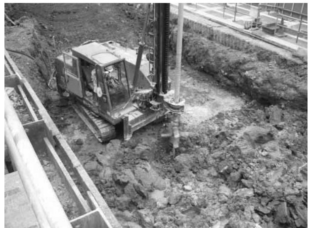
写真-4 地盤改良杭の施工状況
