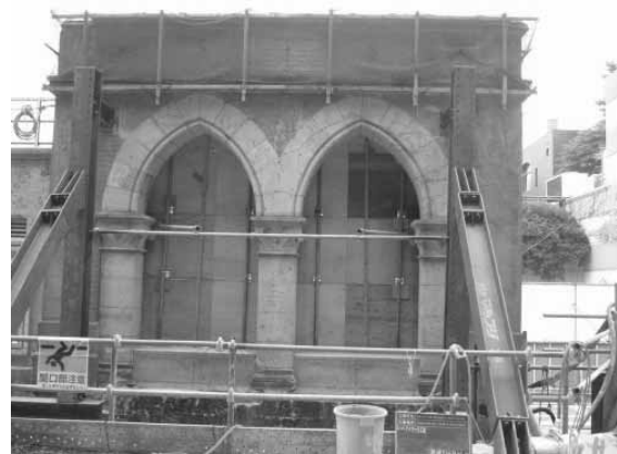
写真-6 保存壁頂部の養生
