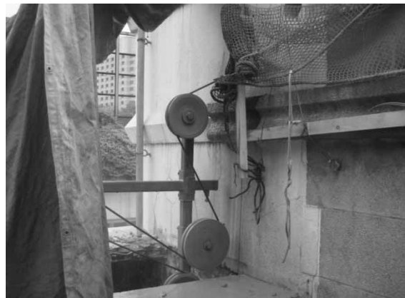
写真-7 ワイヤーソーによる縁切り
