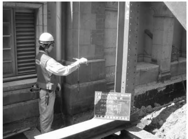
写真-11 保存壁の倒れ計測状況
