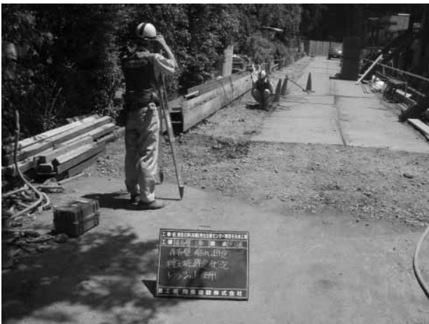
写真-10 控え杭頭の水平変位計測状況
