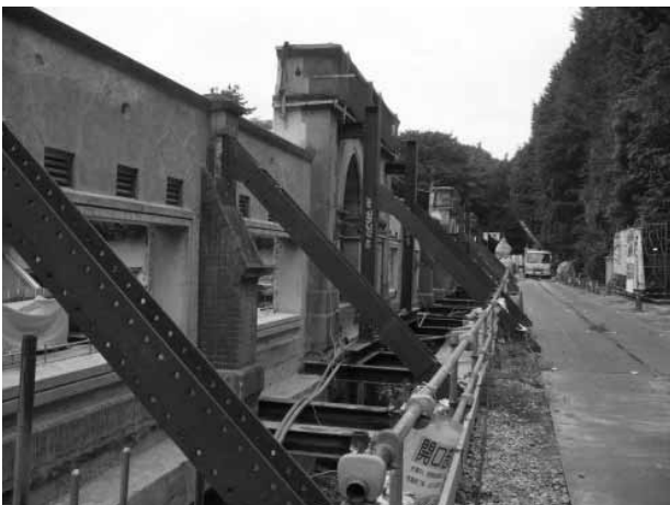
写真-3 保存壁脇の掘削と仮設材設置状況
