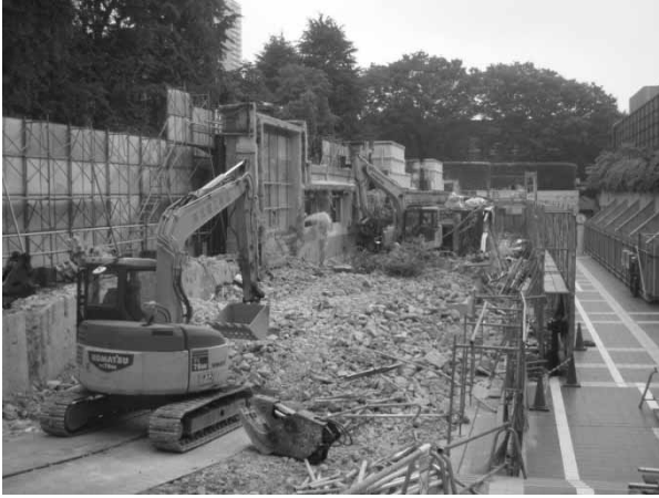
写真-8 重機による解体状況
