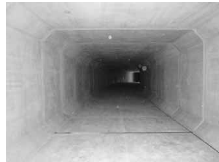
写真-4 推進完了 (管内右100R)
