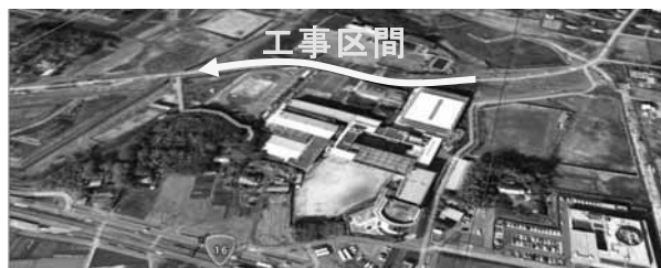
写真-1 施工場所全景
