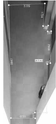
写真-13 共用廊下の適用事例(正射投影後)
