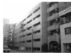
写真-10 外壁面の適用事例(撮影画像)
