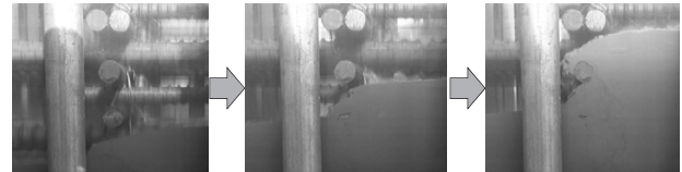
写真-2 最小あき寸法部への充填状況
