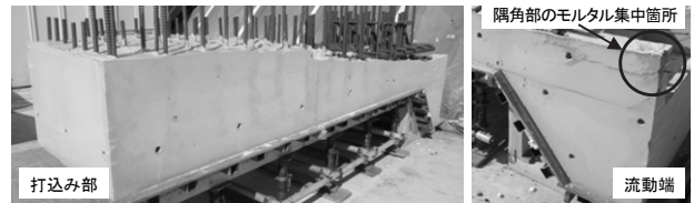
写真-3 実大模擬部材における型枠脱型後の表面状況
