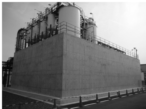
写真 - 1 出来形全景
