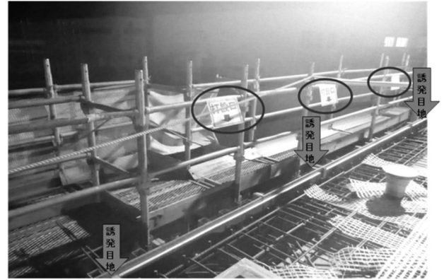
写真-4 打込み口 スラブ状況
