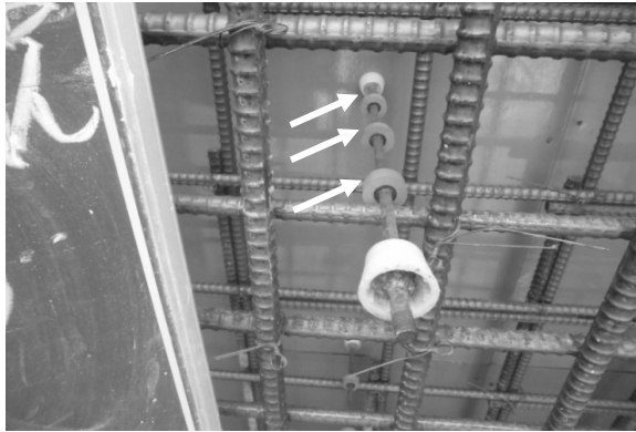
写真-3 止水リング設置状況
