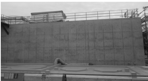
写真-5 壁型枠解体後北面全景
