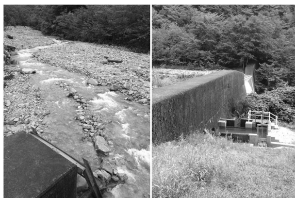
図-3 取水口（左）・取水槽（右中央）
