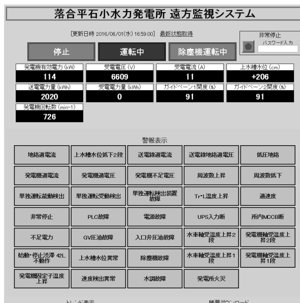
図-15 遠方監視システムのPC画面
