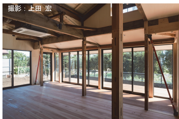
木造用リング摩擦ダンパーの施工実績（研修所）
