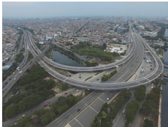
工事竣工全景（2015年12月）
