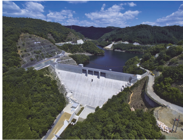
金出地ダム全景（2016年6月）
