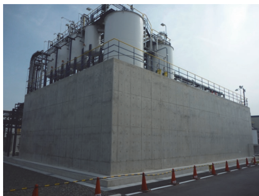
水槽躯体（完成写真）
