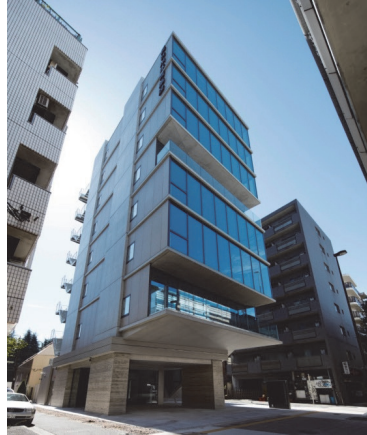
完成写真（北側外観）
