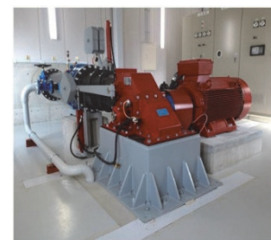
水車・発電機
