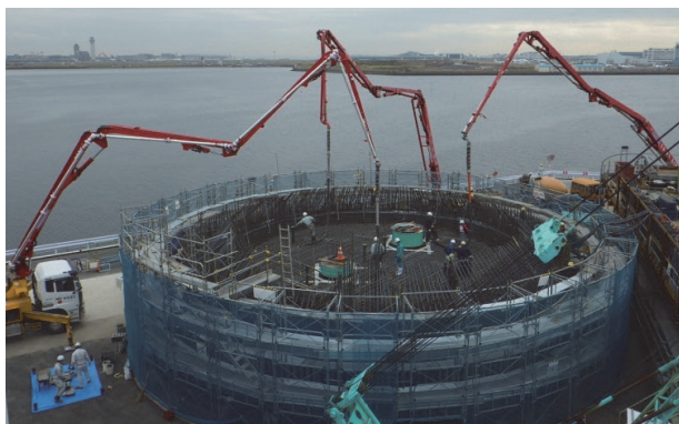
高流動コンクリートの施工状況
