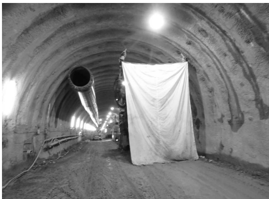
写真-4 防爆シート設置状況
