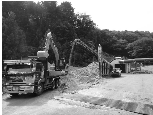
写真-3 坑外ベルトコンベヤ設備
