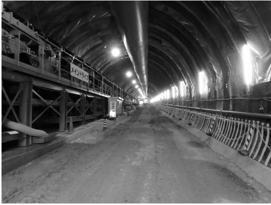
写真-2 連続ベルトコンベヤ設備 (固定側)
