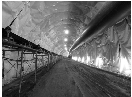
写真-6 ビティ枠 (防水・覆工施工区間)
