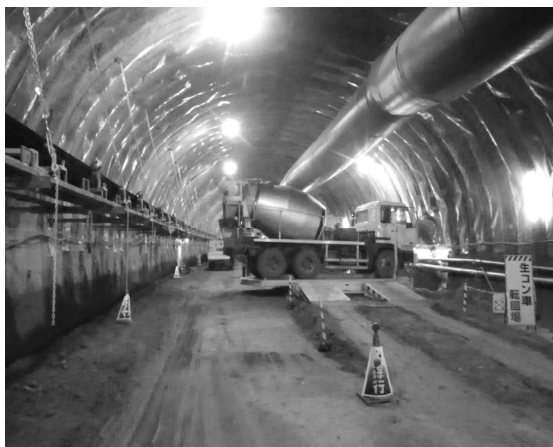
写真-10 ターンテーブル
