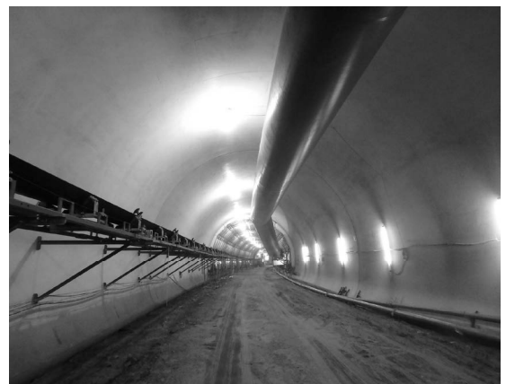
写真-7 ニーブレス型 (覆工完了区間)
