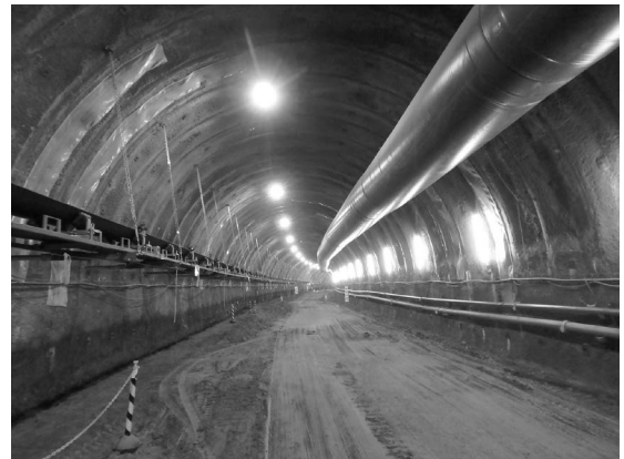
写真-5 吊り下げ型 (掘削完了区間)
