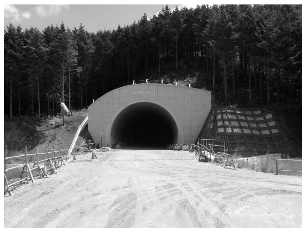
写真-11 終点側坑口付近
