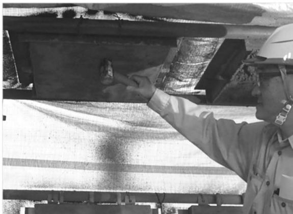
写真-5 吹付け 30 分後の硬化状況
