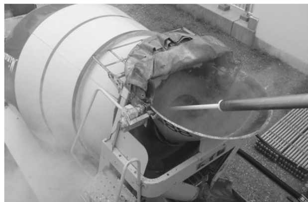
写真-2 液体窒素投入状況
