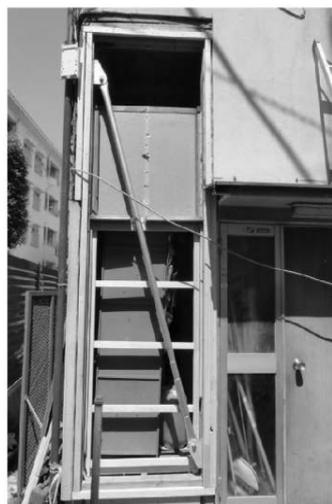
写真-2 リングッドの取付けと壁の仕上げ状況
