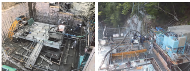
写真-1 コンクリート打設状況
