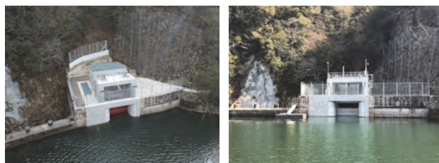
写真-2 完成写真(放流設備)
