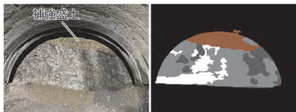
図-4 補強盛土を含む切羽写真の変換例
