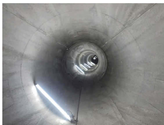
写真-2 二次覆工の仕上がり状況
