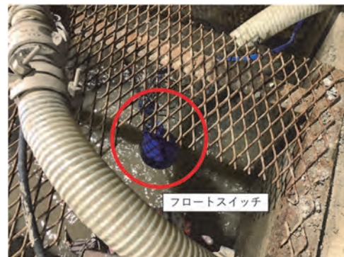
図-6 排水ポンプ稼働確認センサ設置状況
