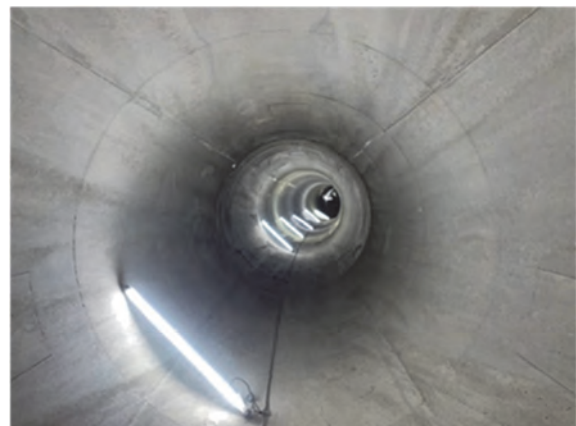
写真-2 二次覆工の仕上がり状況
