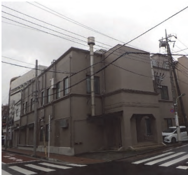
写真-1 対象建物の外観
