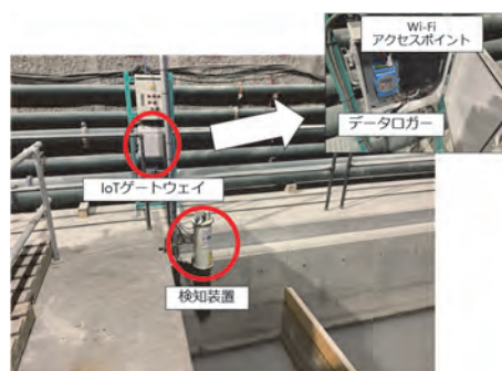
図-2 他社システムと接続したIoT ゲートウェイ
