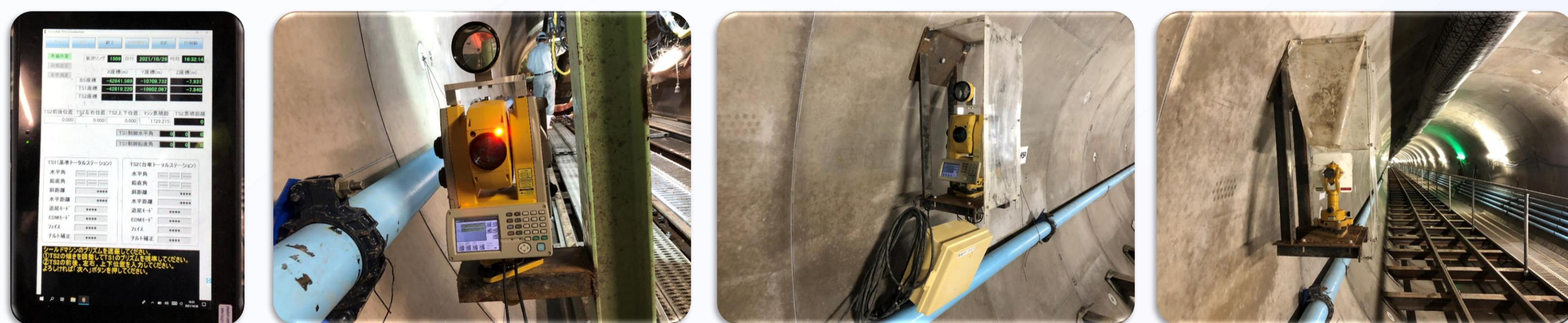
操作タブレット TS2(切羽側トータルステーション) TS1(基準トータルステーション) BS点(バックサイト)
