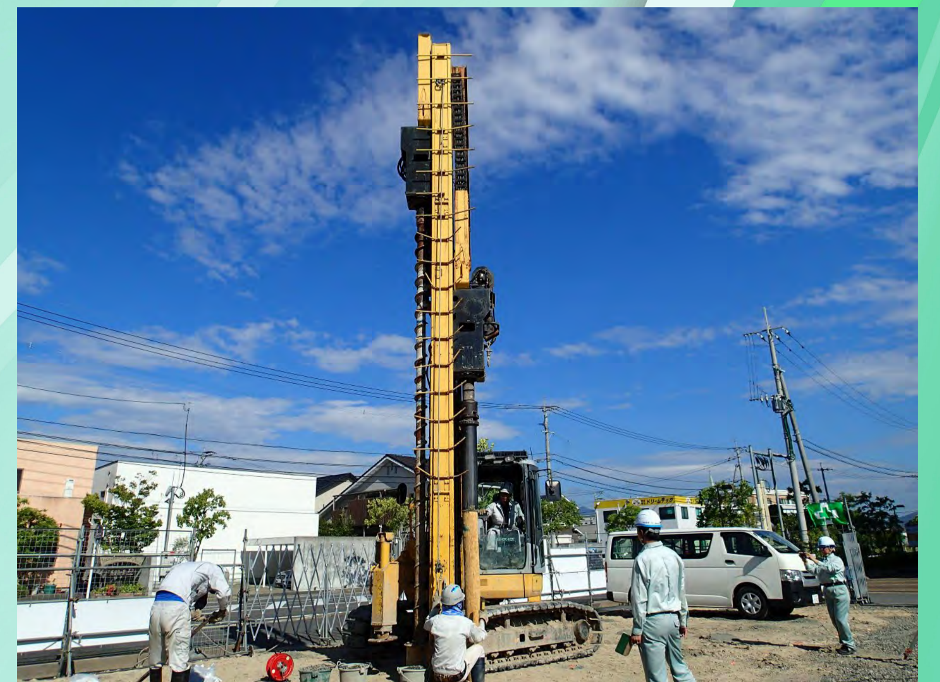
丸太打設による軟弱粘性土地盤対策の施工の様子
