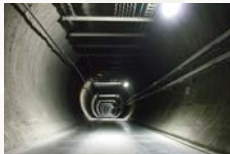
飛驒トンネル避難坑 (岐阜県 / 平成19年)
