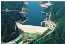
摺上川ダム (福島県 / 平成18年)
