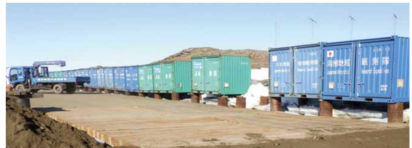
▲コンテナヤード(木製マットを敷設) (撮影:後藤猛)
