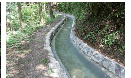
地域の農業用水路の更新・維持管理を事業内で推進
