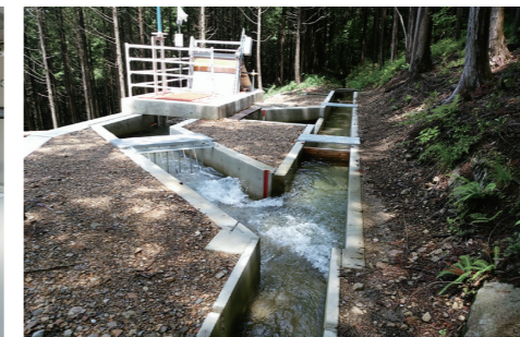
落合平石小水力発電所（岐阜県）
