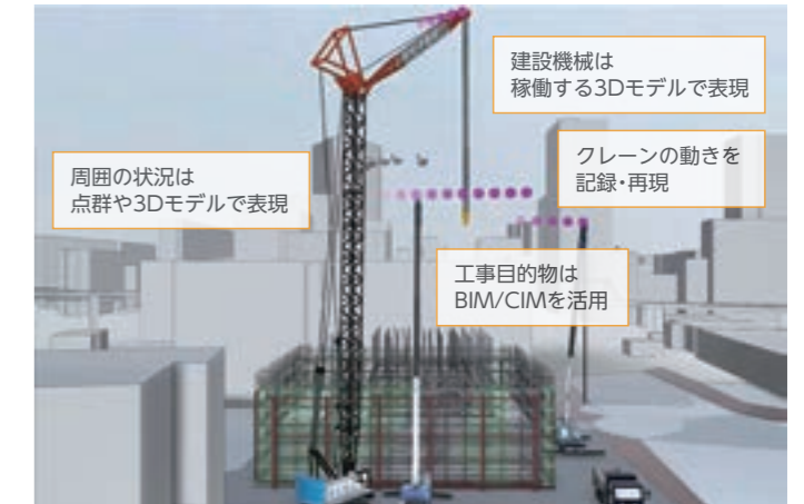
本事例は、ケーソン構築現場において複数のクレーンが稼働する状況でのブームの動きを監視した事例です。
