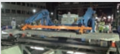
床版撤去状況
