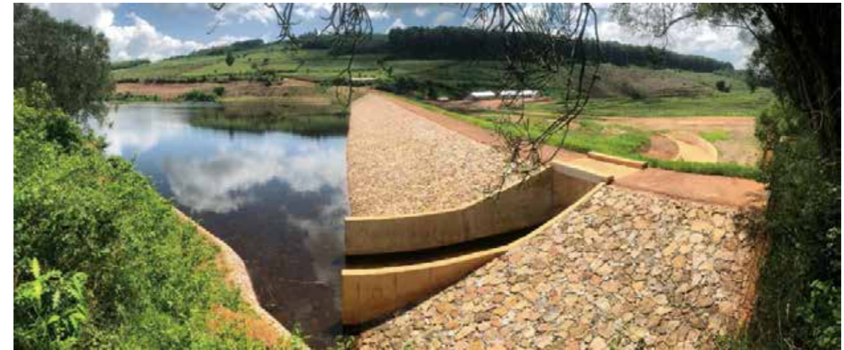
盛立が完了し、農業用水を溜めるチミマ堤体
