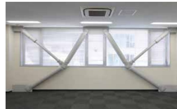
※：建物の変形(A)に対して、ダンパーの変形(B)を2~3倍に増幅
