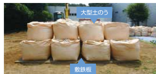
防振堤の設置例
