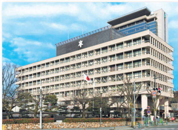
高槻市役所本館耐震改修事業 大阪府 発注者：高槻市
