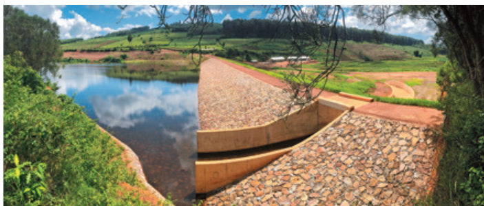
盛立が完了し、農業用水を湛えるチミマ堤体
