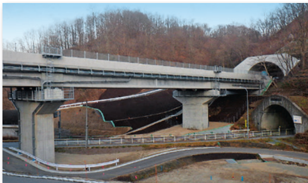
国道106号小山田地区道路工事 岩手県 発注者：国土交通省
