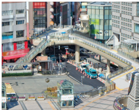
八王子駅北口マルベリーブリッジ西放射線延伸工事 東京都 発注者：八王子市
