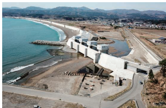
野田地区海岸防潮堤ほか工事 岩手県 発注者：岩手県
