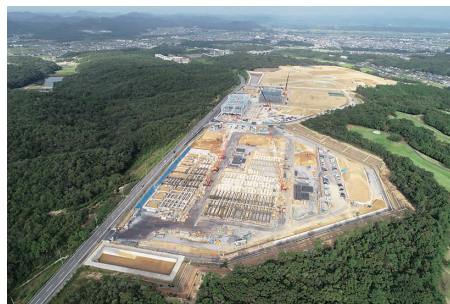
<右上写真> ひょうご小野産業団地造成工事 兵庫県 発注者：兵庫県
