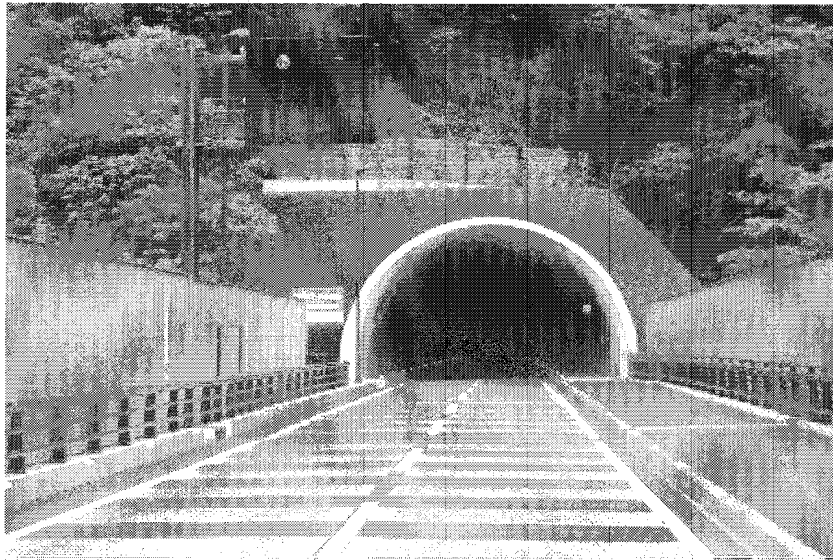
写真-1 境ヶ谷トンネル（四万十トンネル）終点坑口
