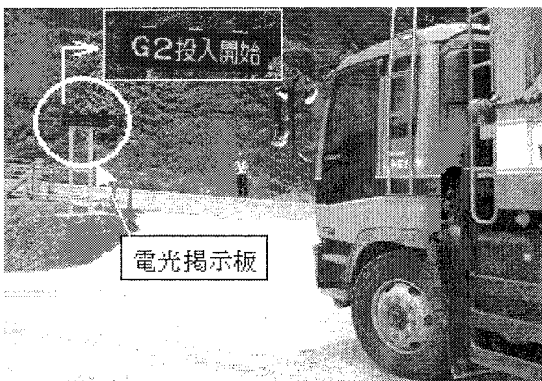
写真-7 骨材投入開始状況 (G2)
