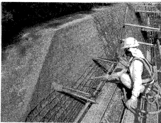
写真-4 吹付け作業状況
