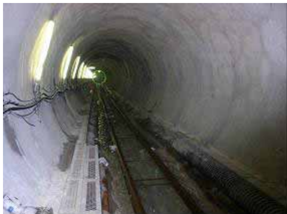
写真-7 白川側吹付け完了状況
