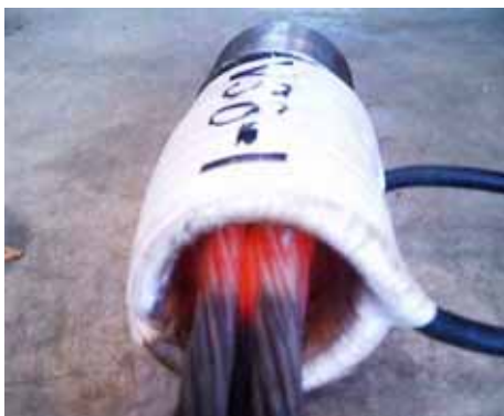
写真-1 PC鋼線加熱状況
