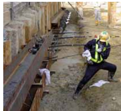
写真-5 人力による引抜き状況
