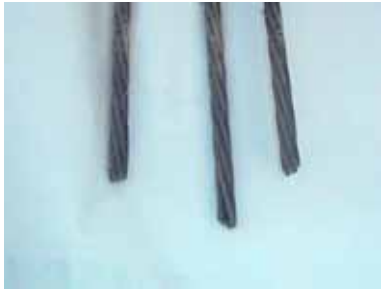
写真-6 PC鋼線切断状況
