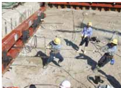
写真-11 人力による引抜き状況
