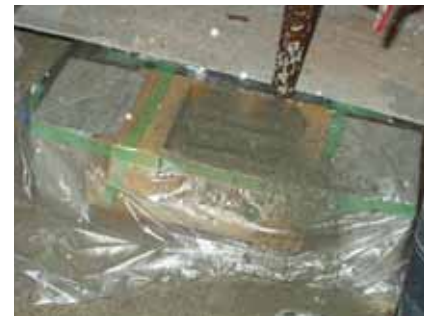
写真-2 試験体作製状況 (吹付け施工による断面修復)
