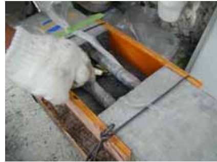
写真-1 試験体作製状況 (下地処理: プライマー塗布)
