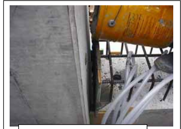
写真-10 目地モルタル施工
