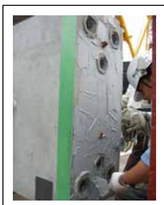
写真-3 ブロック接合面エポキシ樹脂塗布
