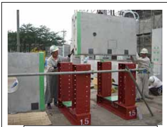
写真-2 ブロック接合部材セット
