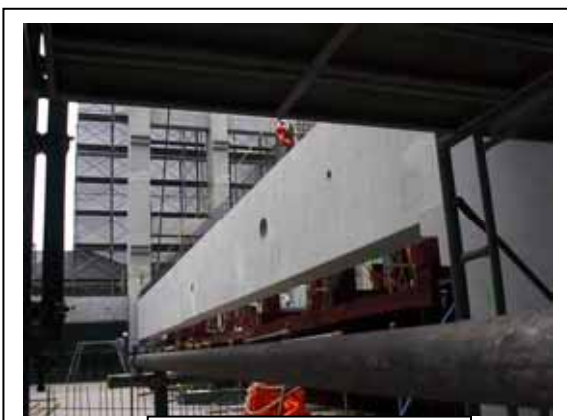
写真-9 PCa 梁 取付
