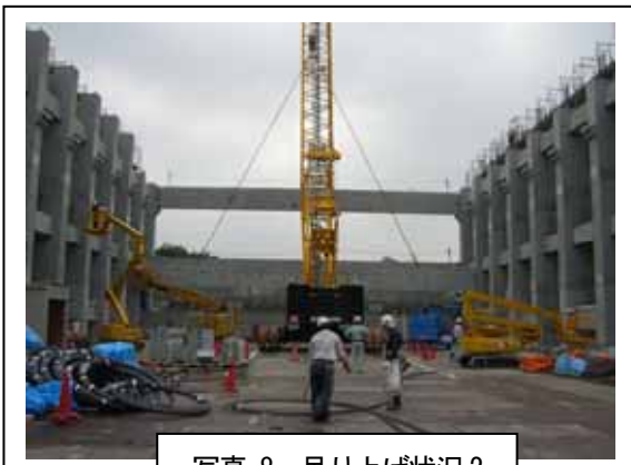
写真-8 吊り上げ状況2
