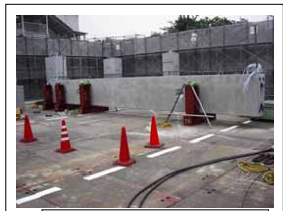
写真-5 ブロック接合 完了
