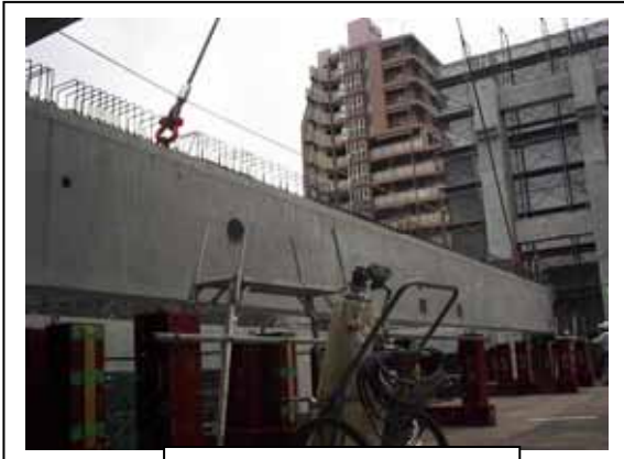
写真-7 吊り上げ状況
