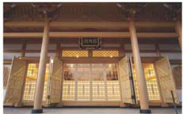
図-5 本堂正面写真
