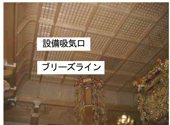
図-6 本堂内陣折上小組格天井写真
