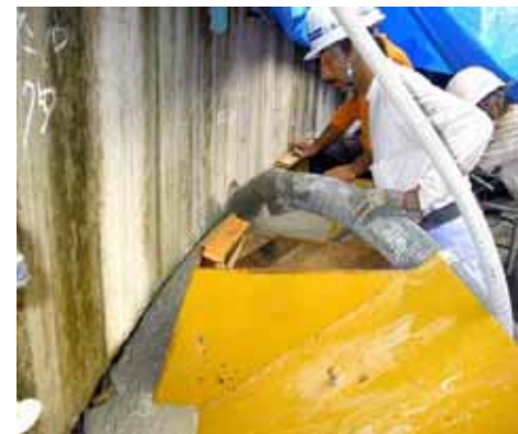
写真-8 高流動コンクリート打設状況
