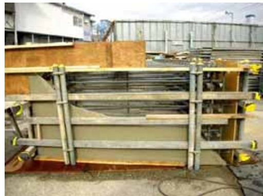
写真-4 流動化コンクリート打設状況（側面）
