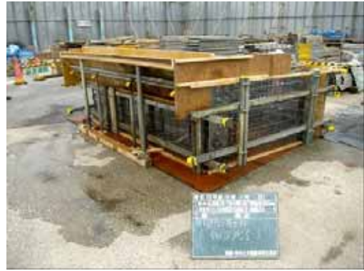
写真-3 模擬試験体（充てん試験用）
