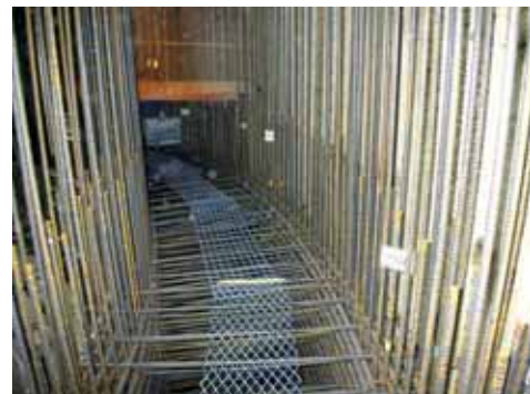
写真-2 側壁内部状況
