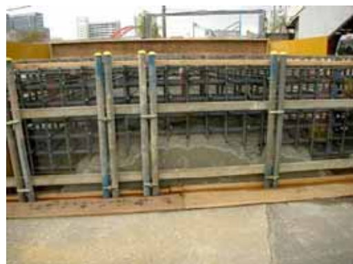
写真-5 流動化コンクリート打設状況（背面）
